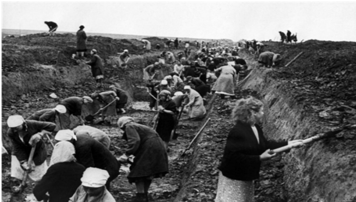
На строительстве оборонительного сооружения. 1941 год.
